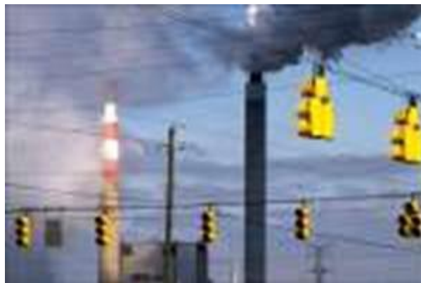
Fotografía de Steven Higos. Central eléctrica de carbón, instalación IPL en el lado suroeste de Indianapolis
