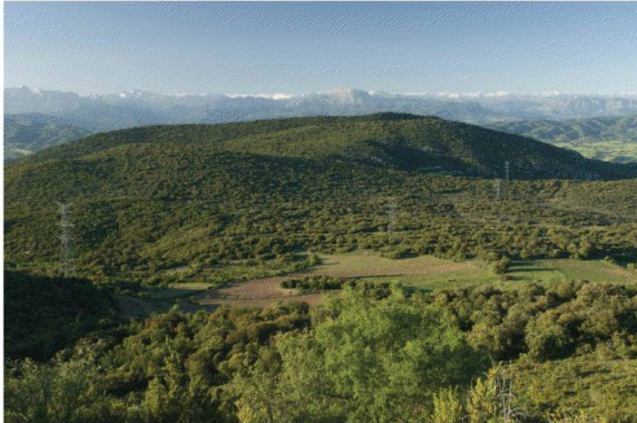
Foto 2: trazado de cinco de las torres por la zona más alta de la Sierra de la Carrodilla, incumpliendo las directrices de Ordenación Territorial del Pirineo Aragonés. Foto: Álex Serrano.
