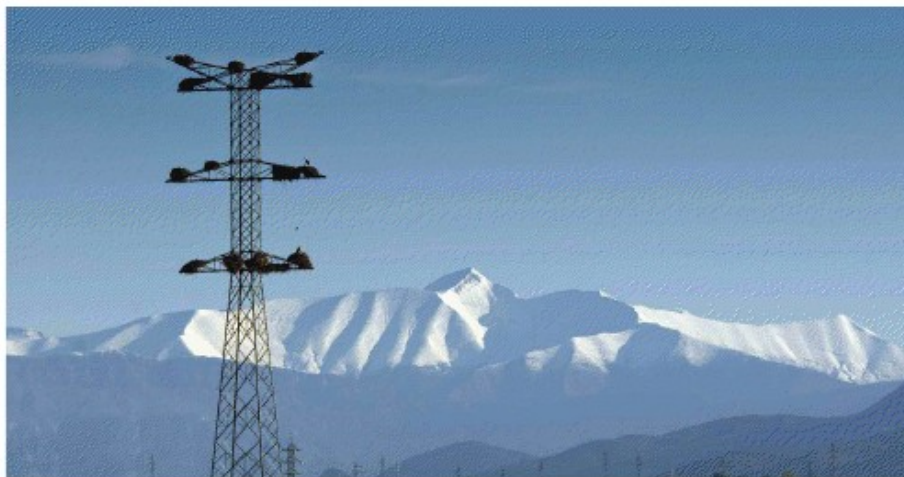
Foto 5: apoyo de la antigua "Aragón-Cazaril", ubicado en Ariéstolas, con 15 nidos de cigüeña. Si se construye la línea los nidos serán derribados.
